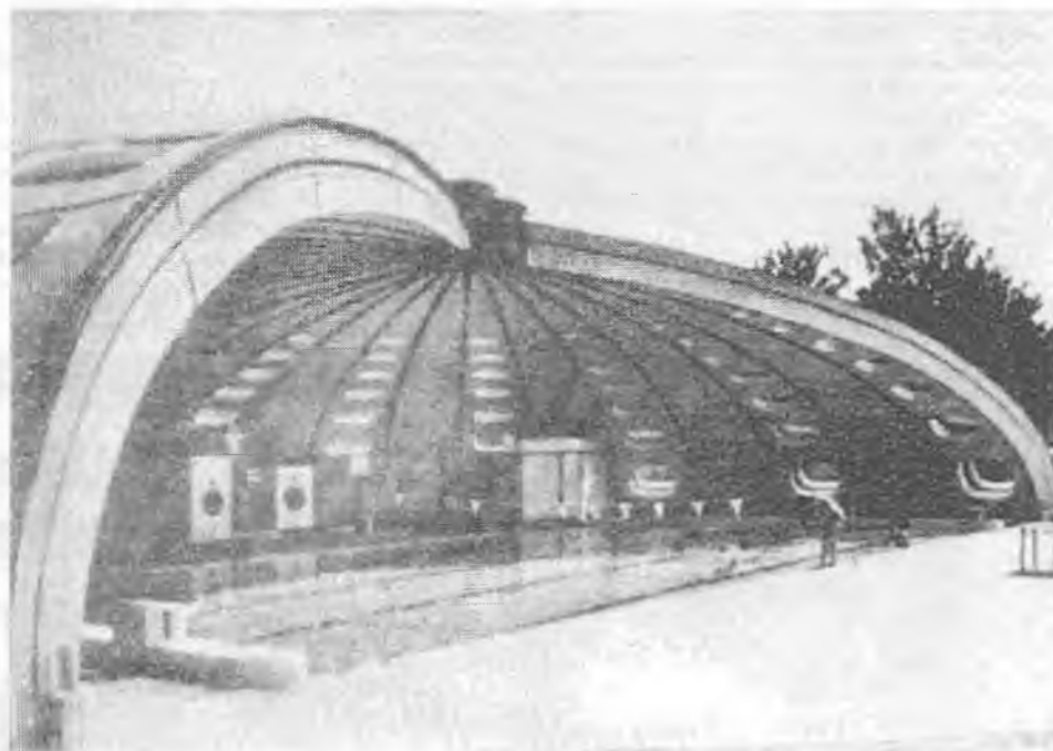
Рис. 6.3. Трансформируемое покрытие бассейна (Франция)
