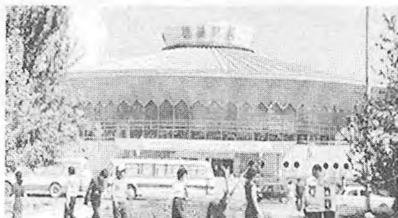
Рис. 8.2. Цирк в г. Бишкек с покрытием в виде складчатого купола
