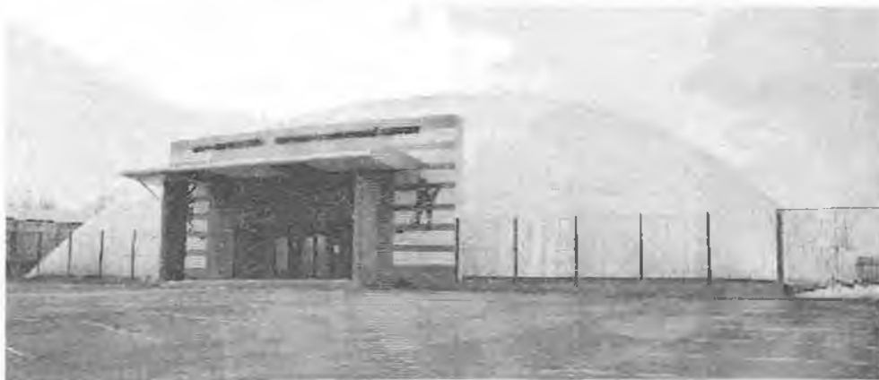
Рис. 8.9. Воздухоопорная оболочка покрытия спортивно-развлекательного комплекса в г. Бишкек
