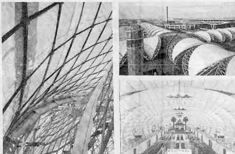
Рис. 5.6. Международный аэропорт в Бангкоке. Общий вид, интерьер и трехслойная оболочка покрытия терминалов.
