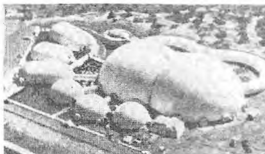
а. Комплекс зданий, перекрытых воздухоопорными оболочками разной формы поверхности (США)
