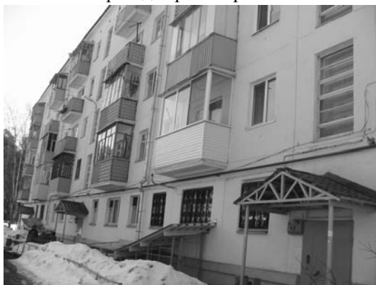
Дом ТСЖ «Содружество» г.Пермь – утепленные балконы, стеклопакеты
