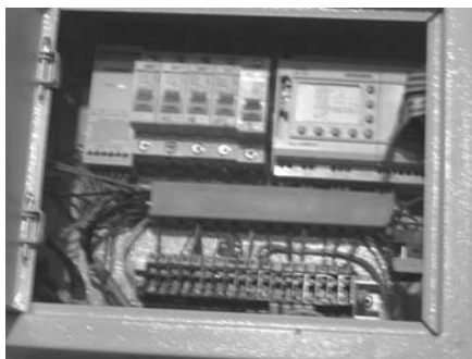
Контроллер – автоматизированный комплекс снятия показаний со счетчиков
