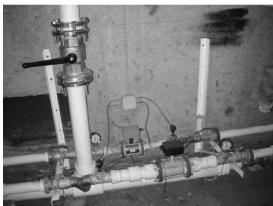
Новый измерительный комплекс и приборы регулирования ресурсопотребления в ТСЖ «Лесной»
