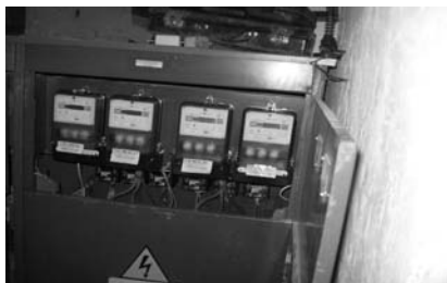
Двухтарифные счетчики электроэнергии
