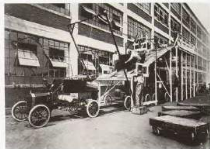
Установка кузова автомобилей Модель Т, 1914
