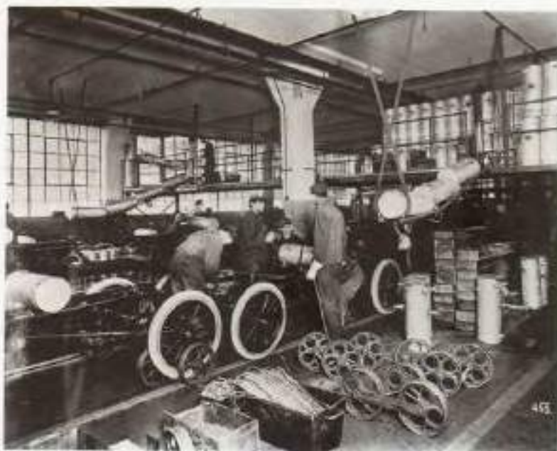
Установка бензоба- ков автомобиля Модель Т, 1914
