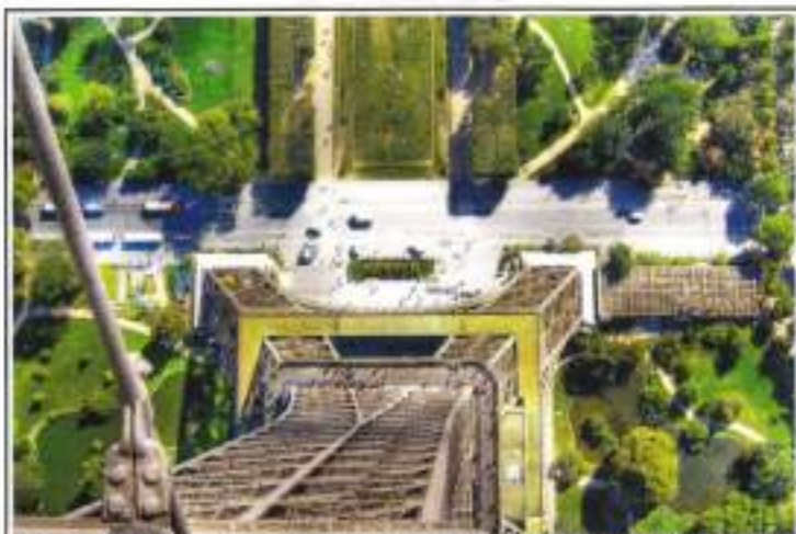
Четыре опоры башни стоят на углах квадрата со стороной почти 130 м. Они соединяются на высоте 57,6 м, образуя первую квадратную платформу со стороной в 65 м. Вторая платформа находится на высоте 115,7 м, третья - на высоте 276,1 м.
