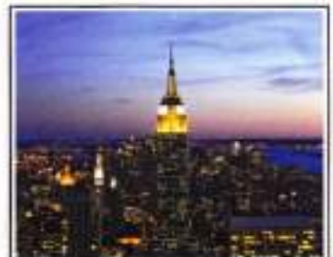
Эмпайр стэйт билдинг строился рекордно быстро — по 4-5 этажей в неделю. На постройку ушло 10 млн. кирпичей и 700 км. кабеля. Плещущий каркас здания создают стальные брусны обшей массой 60 тыс. т., а обшей вес постройки достигает 331 тыс. Общая площадь его окон составляет 2 га. Внутри небоскреба ходят 73 лифта, которые развозят около 50 тысяч работающих внутри здания человек и 35 тысяч индивидуальных посетителей. Самая верхняя обзорная площадка расположена на последнем, сто втором этаже. С нее открывается захватывающий вид на Нью-Йорк. После строительства с вершин площадки небоскреба вниз бросались несколько самолётов. Чтобы предотвратить в будущем такую инциденты, паранет был собран загнутыми внутри железными прутьями.
