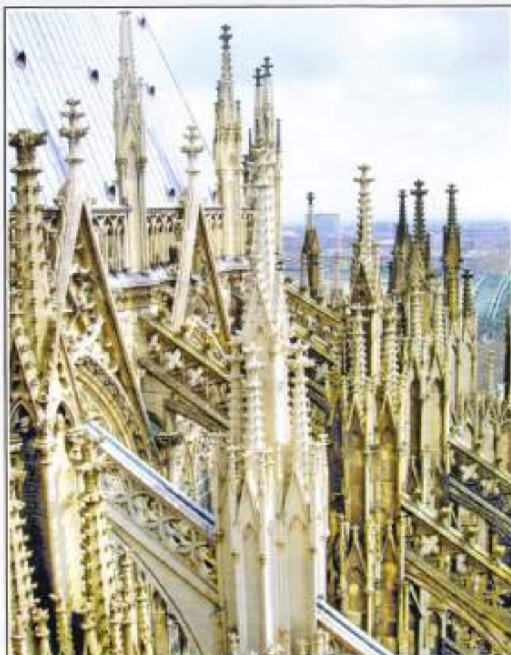
Внутренняя высота боковых нефов собора составляет 19,8 м. Общая площадь крыши — 12 тыс. м 2 . При взгляде сверху видны многочисленные выступающие наружу башенки — пинакли. Они служат наверху для скрепления системы арбутов и контрфорсов, напоминающих своеобразные архитектурные «ребра» собора.
