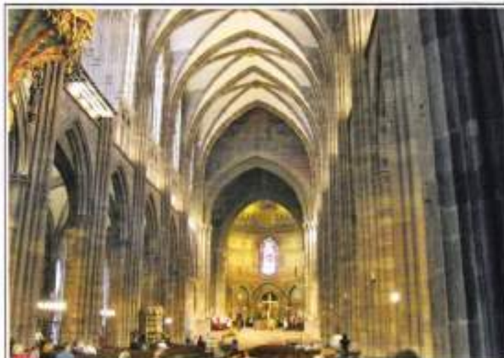
Трансепт и хор собора были выстроены в романском стиле. Элементы готики стали привноситься, когда начинали работы по возведению центрального нефа. Это влияние явно чувствуется, когда смотришь на его устремленные вверх колонны, стрельчатые своды, обращаясь внимание на трибуны этого хора с рядом декоративных окон и знаменитую готическую аркаду в боковых нефях. Любопытен также опорный столб восточной виадуэстрии, поднимающийся до самого свода. Для того чтобы различия в стиле двух частей здания не слишком бросались в глаза, строители объединили их общими элементами профилей. Центральный неф возводили на фундаменте старой церкви. В результате его ширина оказалась необычно большой: она составляет 36 м (высота нефа - всего 32 м).
